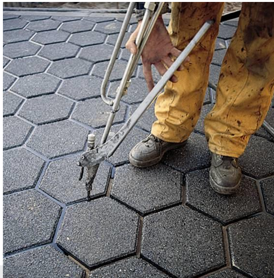
Foto: Voorbeeld van het aanbrengen van voegvulmassa.
